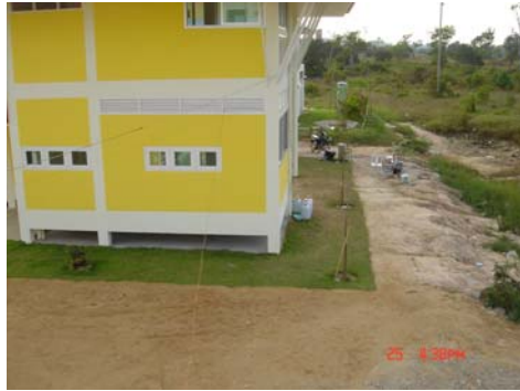
บริเวณติดตั้งเครื่อง Data Logger อยู่ที่ห้องครัวชั้นล่างของบ้านไม้ไผ่พร้อม
