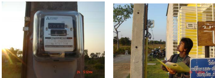
รูปที่ 5.6.ภาพแสดงเครื่องมือวัดมิเตอร์ไฟฟ้า และการจดบันทึกหน่วยไฟฟ้า
