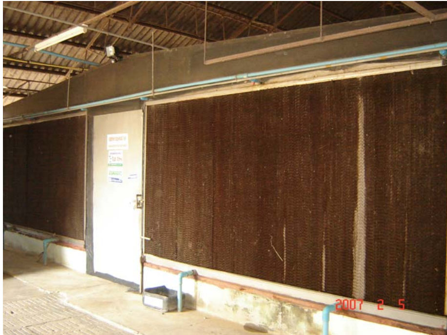
รูปที่ 4.7 Cooling Pad ด้านหน้าโรงเรือน
