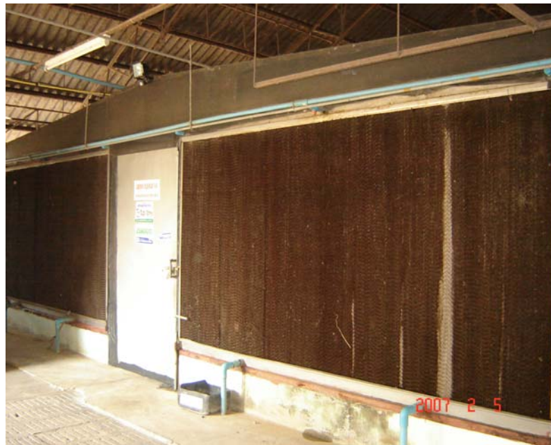
รูปที่ 4.4 Cooling Pad ด้านหน้าโรงเรือน
