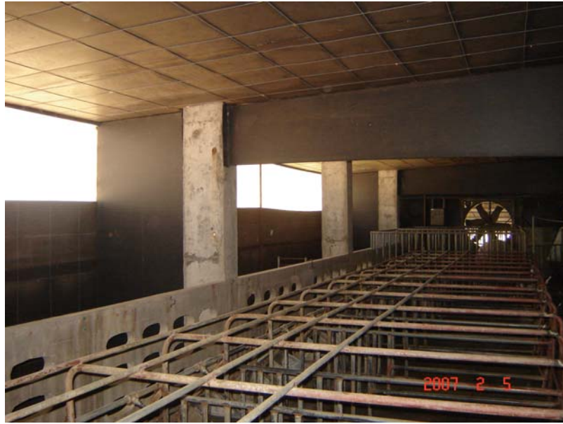
รูปที่ 4.3 แผงกั้นคอกด้านข้างและคานบนโรงเรือน
