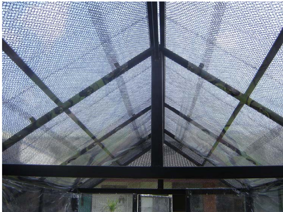
รูปที่ 4.4 หลังคาเรือนอบฟิชคลุมด้วยพลาสติกใสสองชั้น
