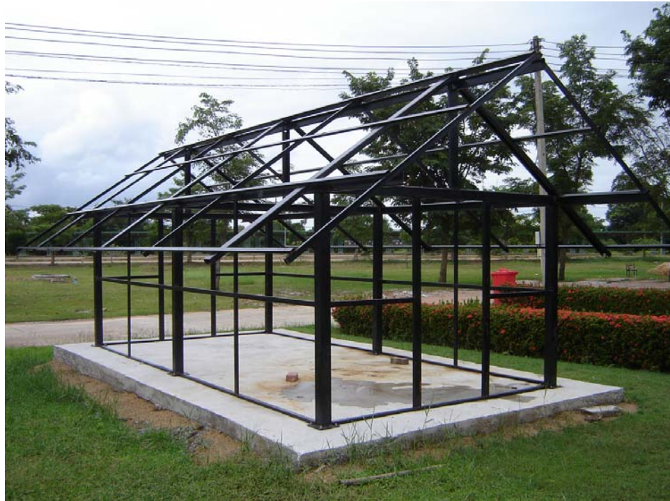
รูปที่ 4.2 โครงสร้างเรือนอบพีชที่สร้างจากเหล็ก
