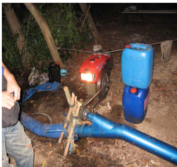
รูปที่ 3.2 การติดตั้งชุดทดสอบ
