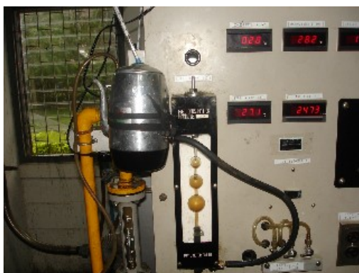
รูปที่ 3.1 แสดงการติดตั้ง Heater
