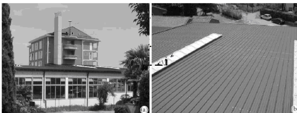
รูปที่ 2.5 แสดงการประยุกต์ใช้งาน Large Unglazed Solar Panel Collector ในการทำความร้อนให้กับสระว่ายน้ำ
